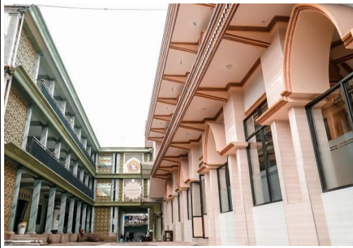
Bangunan Pondok Pesantren Kampus 1
