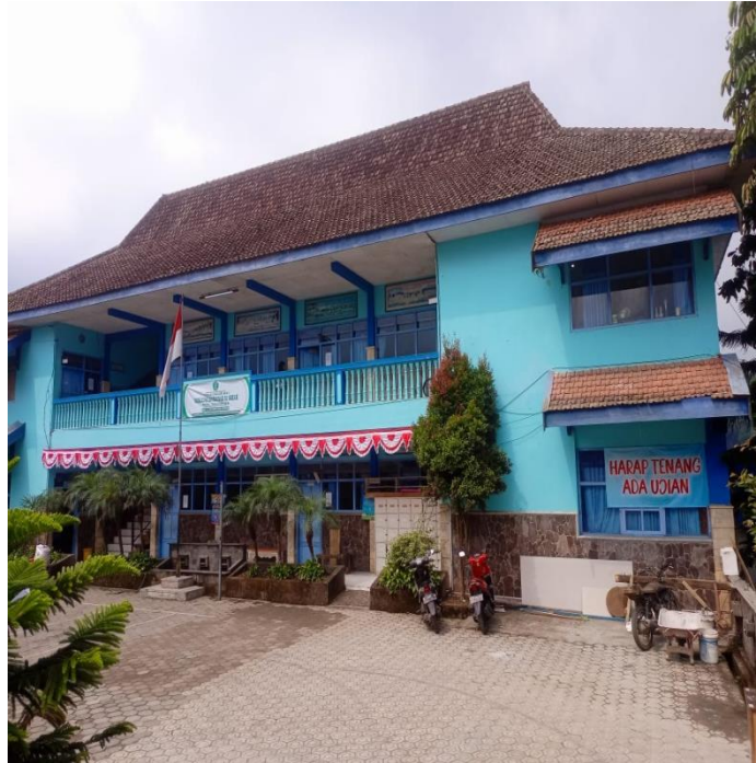
Gambar 7. Gambar Gedung MI Al-Ishlah dari samping depan
